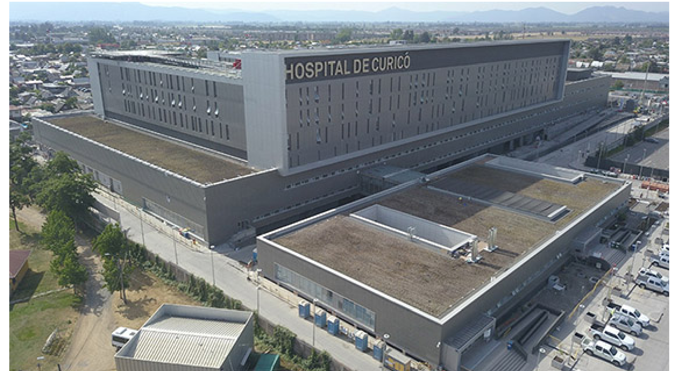
Hospital de Curicó. Chile
