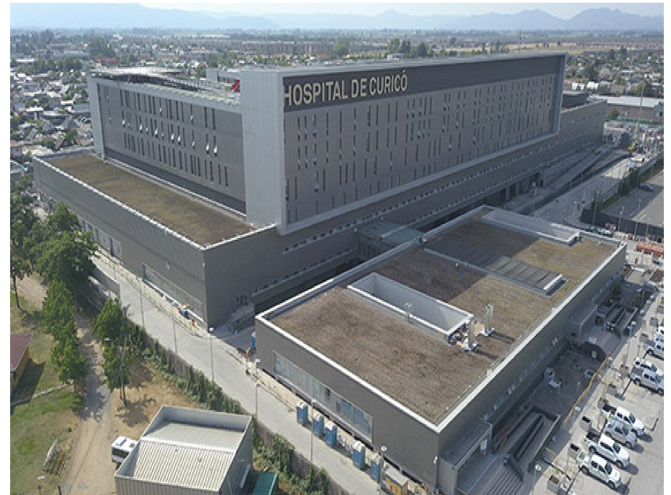
Hospital de Curicó. Chile
