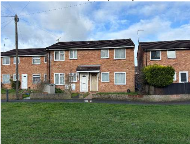
BH12 4EG, 17 Aspen Way
